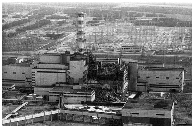
Рис. 2 Разрушенный энергоблок Чернобыльской АЭС
